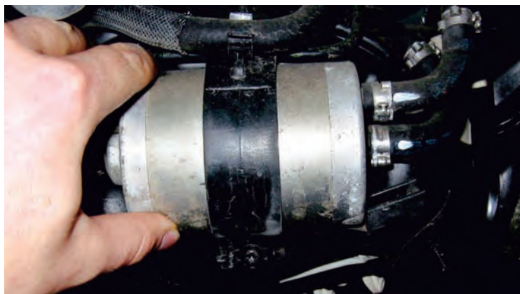
Abb. 6 Kontaktkorrosion aufgrund beschädigter Isolierung
