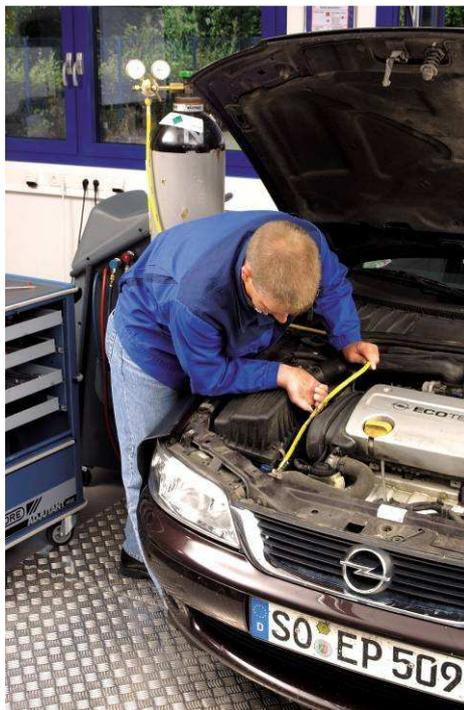
**Bild 2** Systemkomponenten werden mit unter Druck stehendem Stickstoff (ca. 12 bar) über eine Druck-Armatur ausgeblasen.
