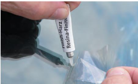
Heben Sie die **Aushärtefolie** von oben leicht an (bis kurz unter den Einschlagkrater), geben einen Tropfen **Finish-Harz** direkt auf den Einschlagpunkt und lassen Sie die **Aushärtefolie** wieder auf die Scheibe zurück gleiten.
