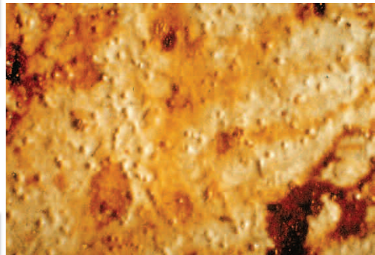
Lackfilmrückseite mit starken Unterrostungen 20-fach Vergrößerung
