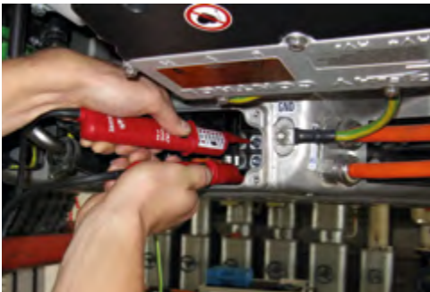
Bild 3: Spannungsfreiheit feststellen
