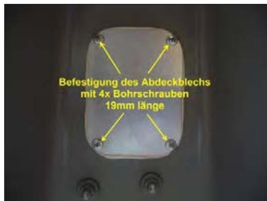
Bild 15: mit 4x Bohrschrauben befestigen
