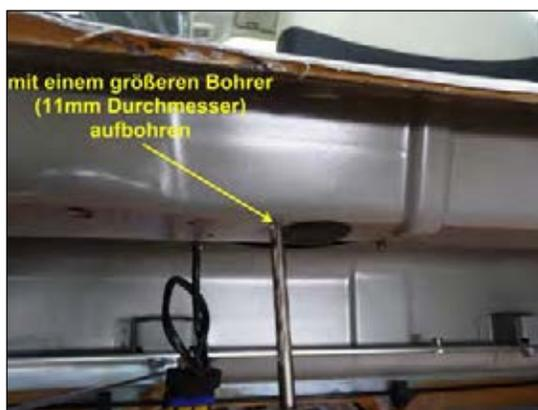
Bild 9: Bohrstelle aufbohren
