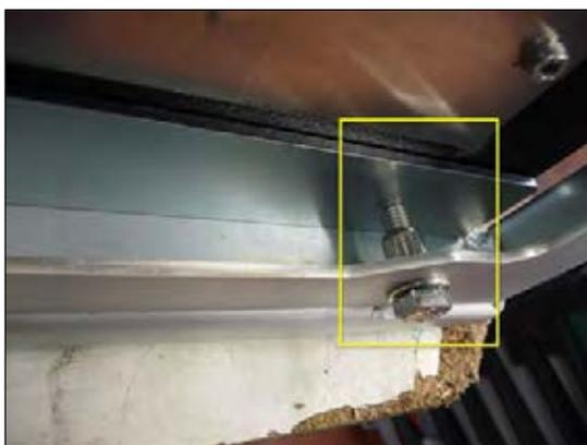
**Bild 11: Sicherungsplatte fixieren**
