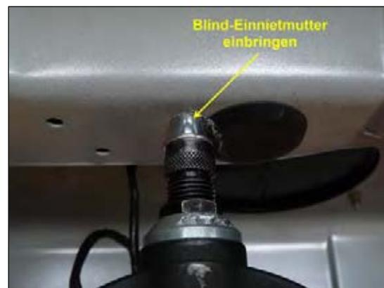
Bild 10: Bohrstelle vernieten
