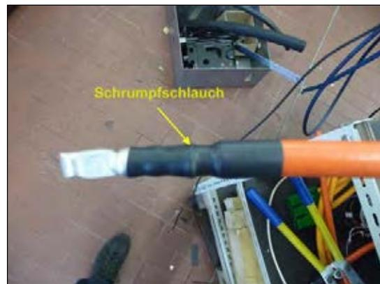
**Bild 18: HV- Kabel mit Schrumpfschlauch**
